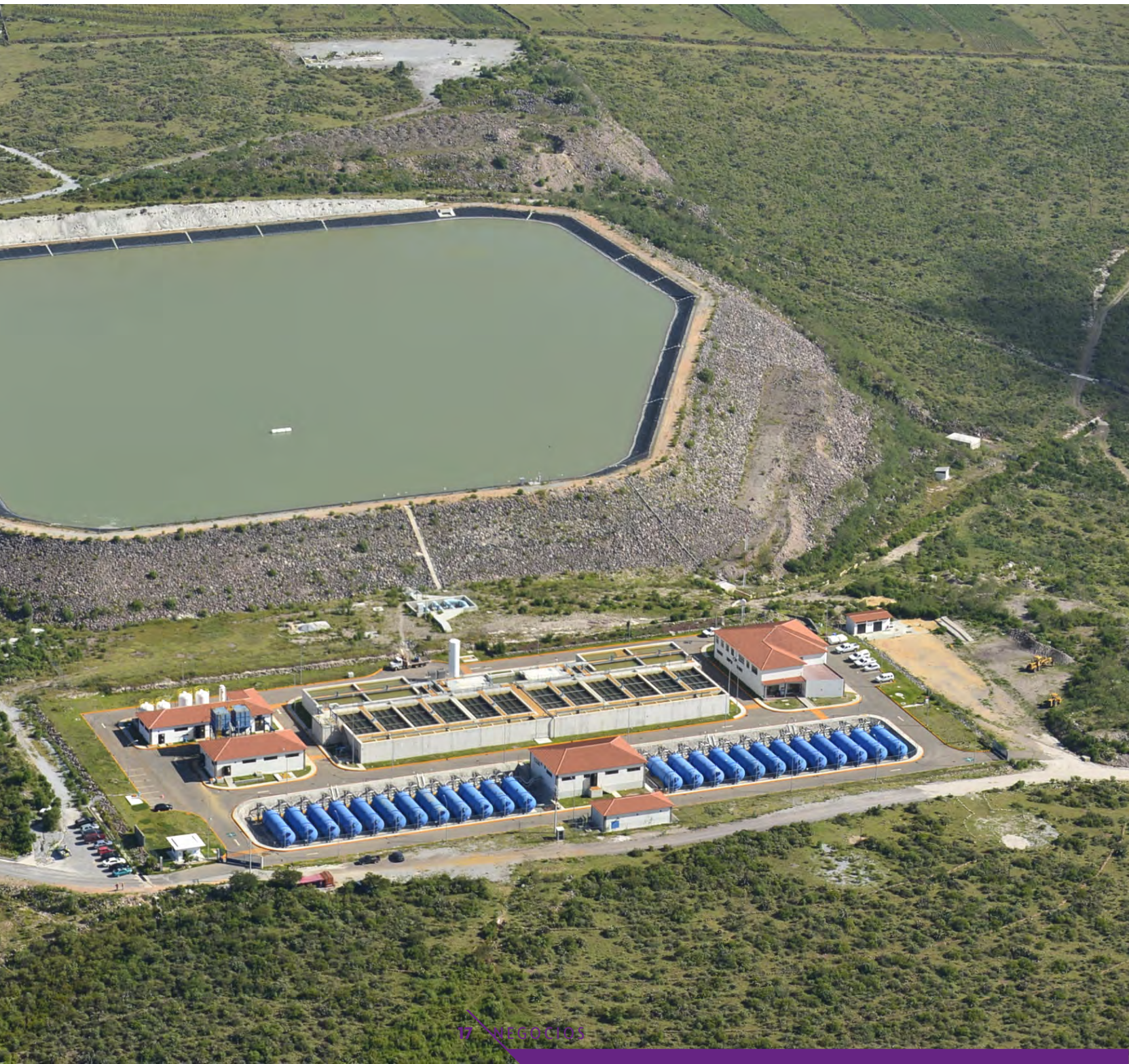
Sistema Acueducto II de Querétaro. Estación de Tratamiento de Agua Potable de San Javier (México).
