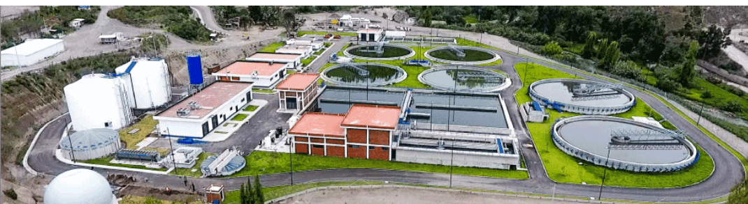
PTAR de Ambato (Ecuador).
