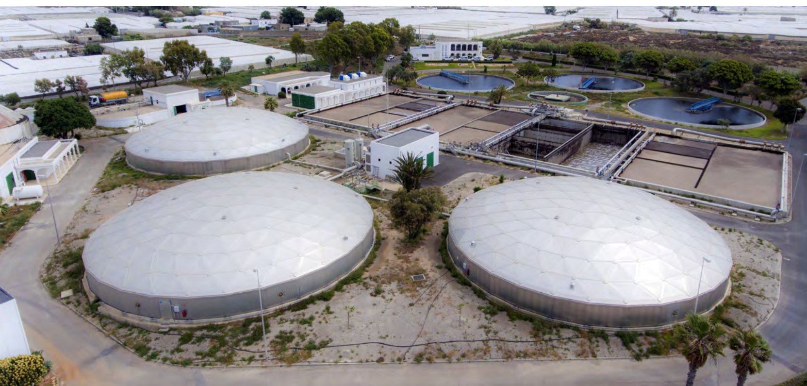
Estación Depuradora de Aguas Residuales (EDAR) de El Bobar, en Almería (España).
